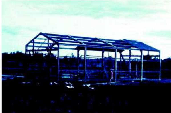
Figura 6 El galpón de aluminio en construcción.
