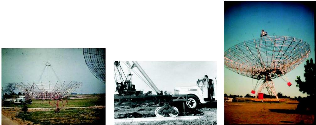
Figura 28 *Izquierda:* El disco de la Antena 2 terminado. *Centro:* La plataforma móvil para la Antena 2. *Derecha:* La Antena 2 montada sobre la plataforma móvil.
